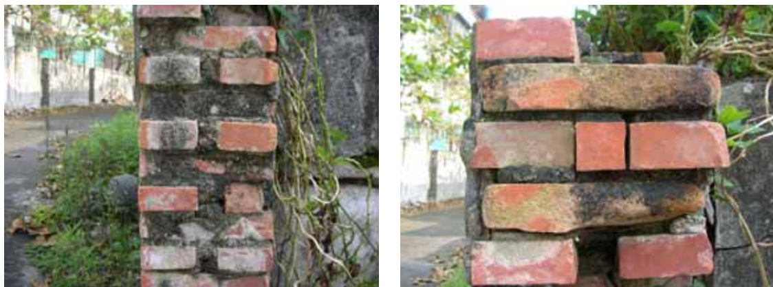
照片 4-34 內院左側院牆磚牆砌法
