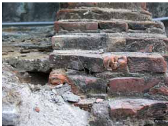
牢房外牆之閩南磚
