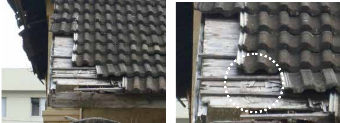
照片 4-67 屋面板上的木片防水層及掛瓦條
