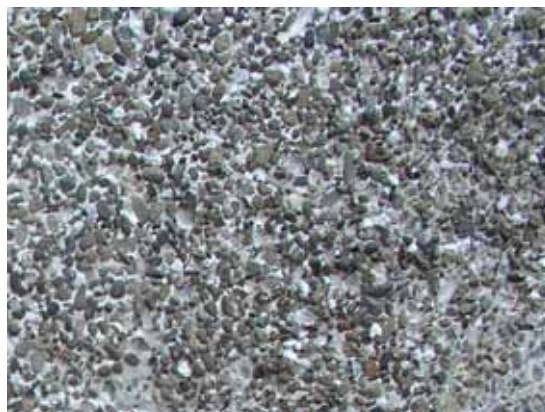
照片 4-41 水產試驗場牆體之洗石子
