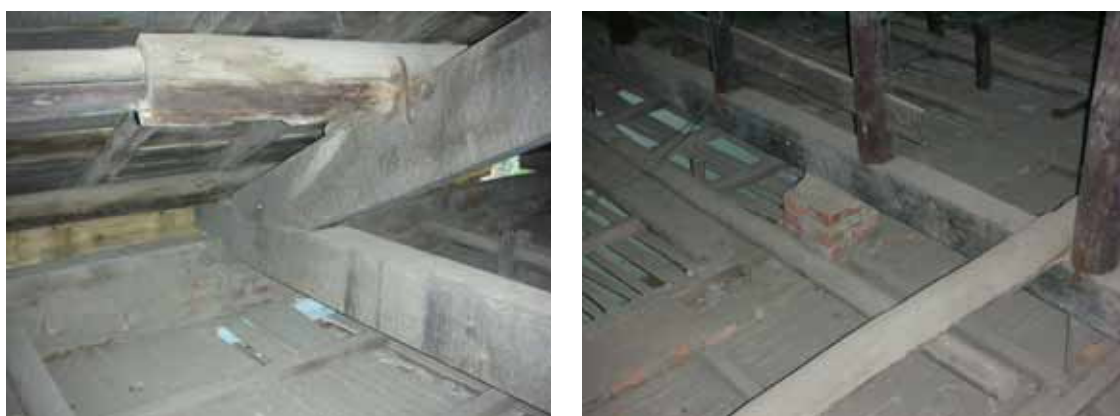
照片 4-65 陸樑架設：直接架在軒桁及內牆頂之磚基座上
