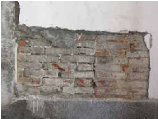
照片 3-20 西側壁面門孔痕跡
