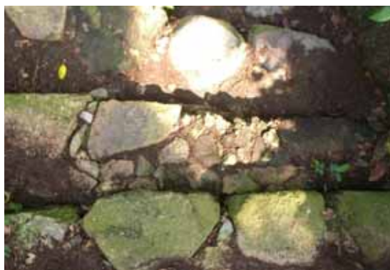
照片 4-110 石砌階梯
