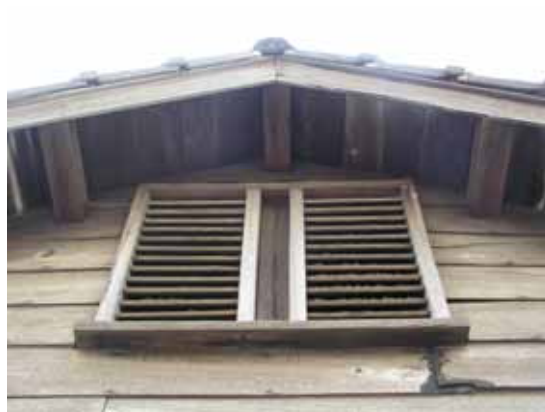
照片 4-43 水產試驗場雨淋板
