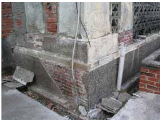
照片 3-28 基座洗石子下方的磚面
