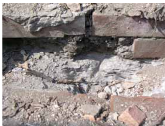
照片 4-23 基礎砗咕石放腳
