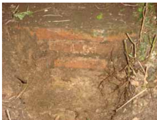
照片 6-2 基礎原貌
