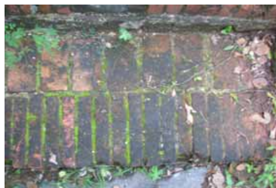
照片 4-113 紅磚砌築階梯
