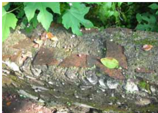
照片 4-115 階梯旁的矮牆頂端覆瓦
