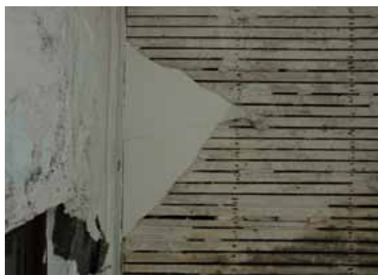
木製線板及木條抹泥天花板
