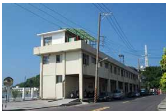
照片 7-5 海巡所的二層建築
