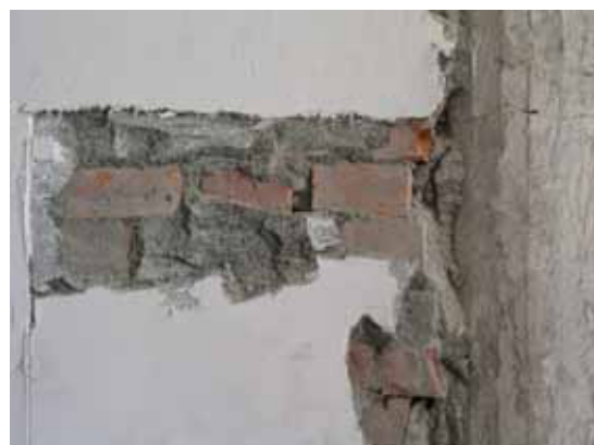
照片 3-23 圓柱靠中央側的填磚
