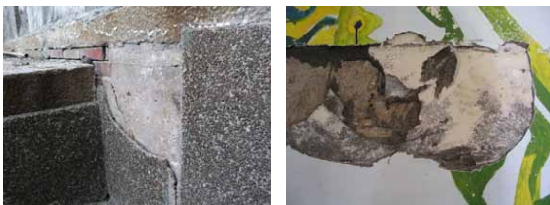
照片 4-35 水產試驗場牆體之白灰粉刷層
