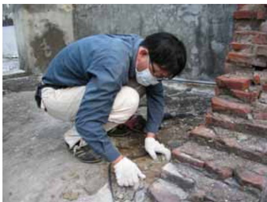
照片 3-11 牢房基址地坪表面水泥粉刷層清理及尺磚鋪面
