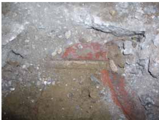
照片 3-12 原牢房之尺磚地坪及鋪面紋理 照片 3-13 尺磚地坪下方之灰土層
