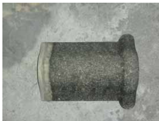
照片 4-71 大棟及隅棟瓦
