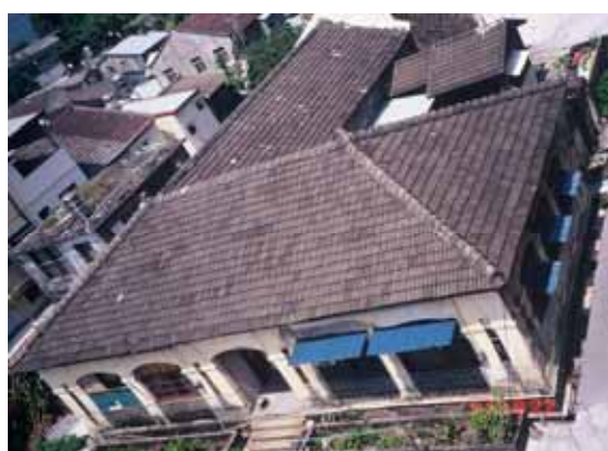
照片 4-70 水泥瓦屋頂現況
