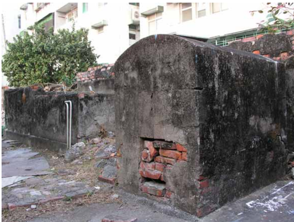
內院和式小屋左側焚化爐
