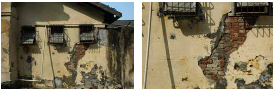
照片 3-27 原辦公區北側僕役房的東側外牆的清理
