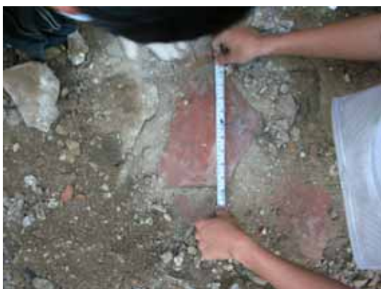
照片 3-12 原牢房之尺磚地坪及鋪面紋理 照片 3-13 尺磚地坪下方之灰土層
