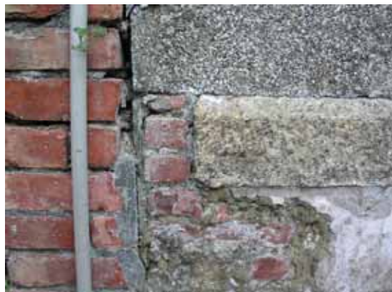
照片 4-36 台基與屋身的接續處置以花崗石石條 照片 4-37 台基易以洗石子
