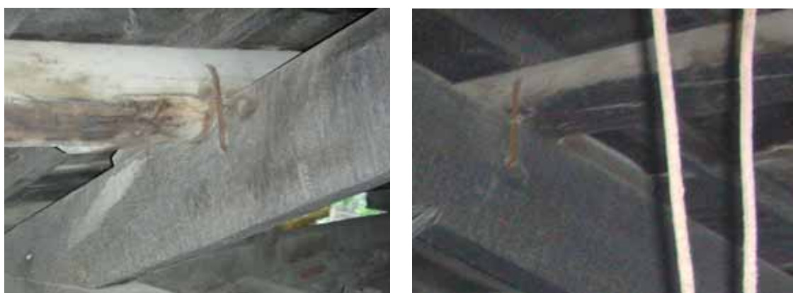
照片 4-66 母屋（桁條）的固定方式
