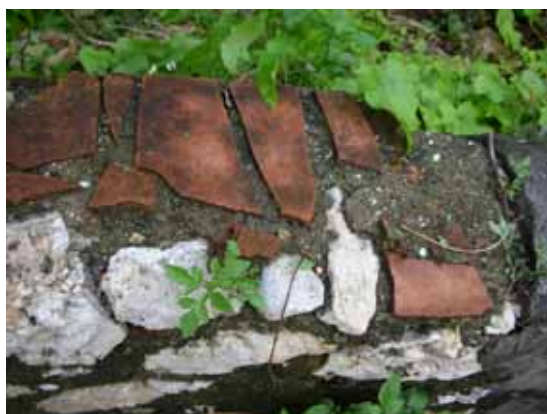
照片 6-43 矮牆頂端壓瓦破損剝落
