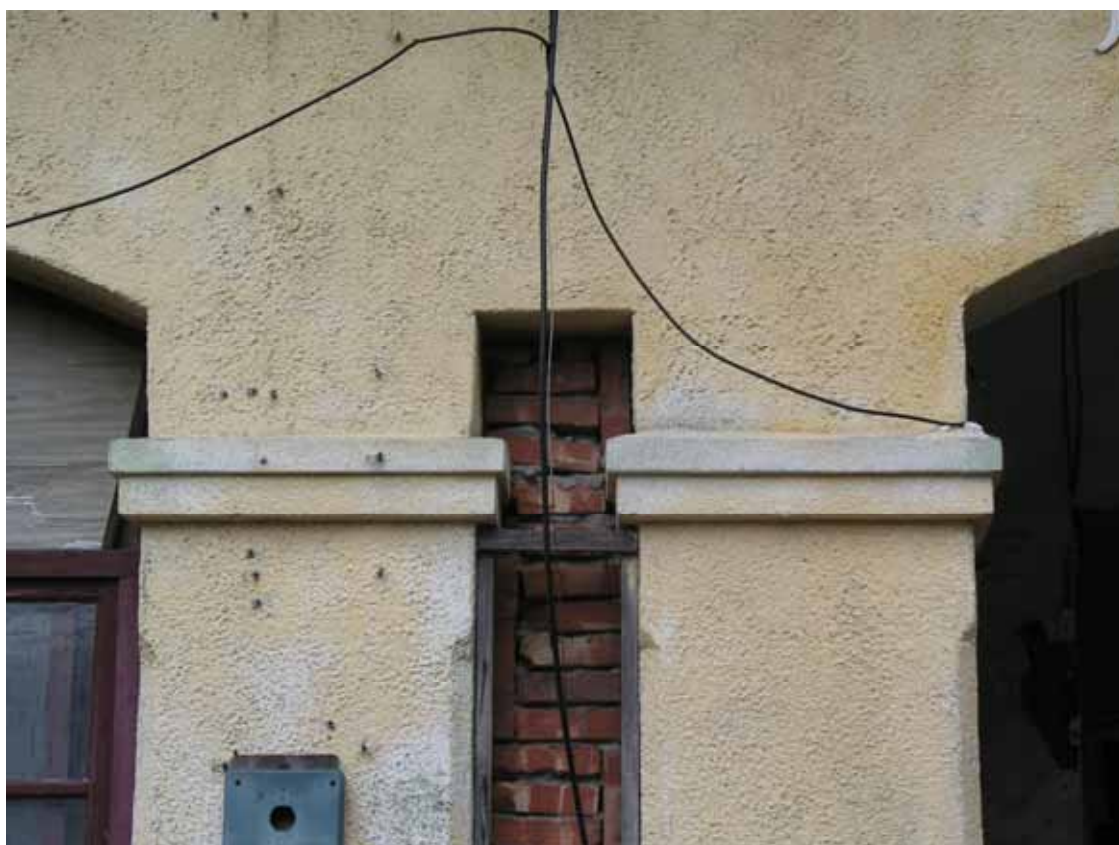
迴廊磚柱：併柱
