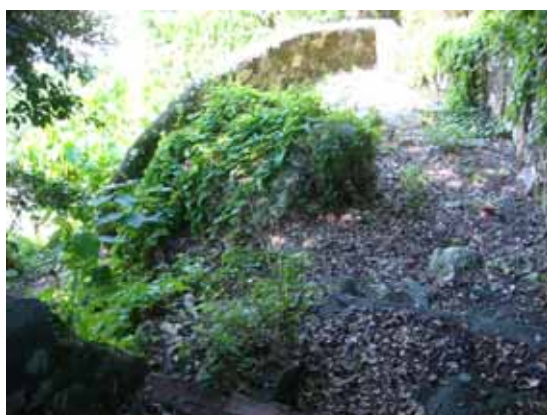
照片 6-42 砗咕石崩塌撞擊致使矮牆佚失
