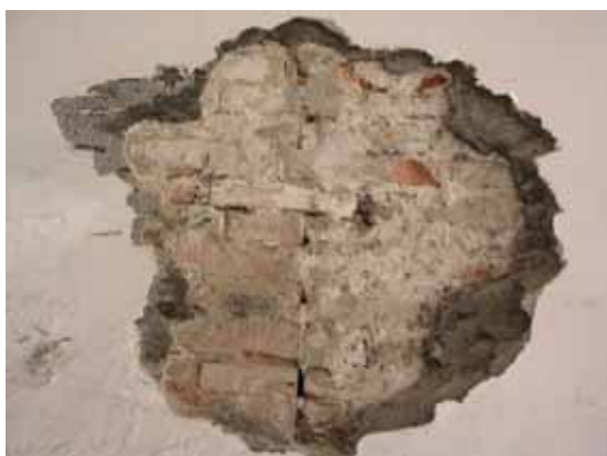
照片 3-18 東側壁面局部清理結果
