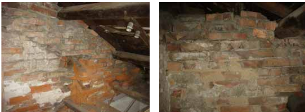
照片 5-7 船務辦公室北側的僕役房現場留存在磚牆上的原屋頂痕跡
