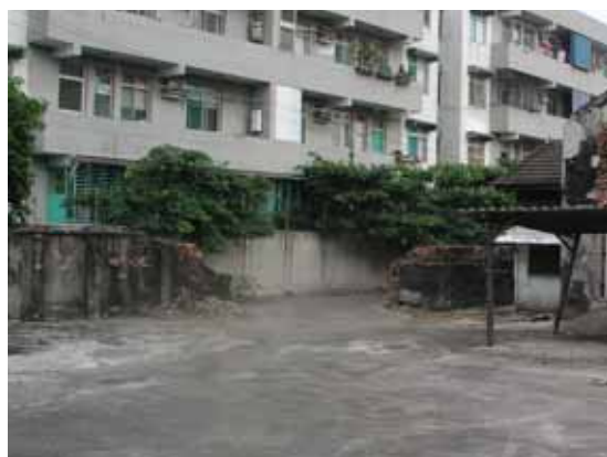
照片 4-99 牢房東側拆除之圍牆及停車場
