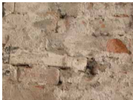
照片 3-19 紅磚表面留有白灰粉刷的殘跡
