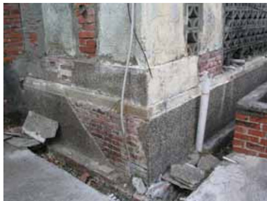
照片 4-36 台基與屋身的接續處置以花崗石石條 照片 4-37 台基易以洗石子
