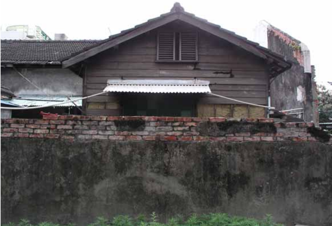
巡捕房左側增建和式小屋及內院院牆
