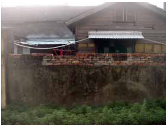
照片 6-35 巡捕區磚造圍牆
