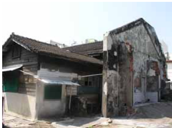
照片 4-42 水產試驗場真壁造
