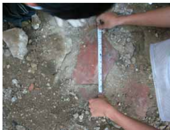
照片 6-4 中央廊道尺磚地坪殘跡及牢房完整尺磚地坪
