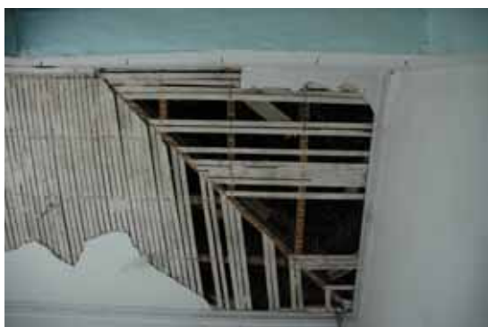
照片 3-31 迴廊的漆喰天井
