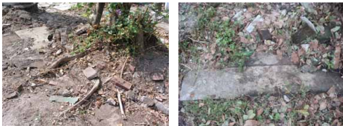
照片 3-15 原牢房階梯及放風庭院地坪的清理
