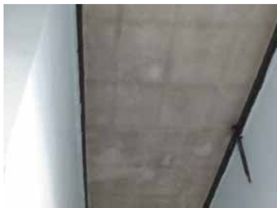
照片 6-23 水泥粉刷塗抹於灰泥表面
