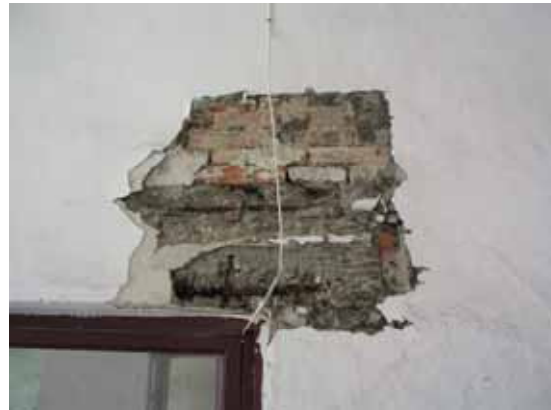
照片 3-21 西側門上方之鋼筋混凝土門楣
