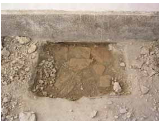
照片 6-4 中央廊道尺磚地坪殘跡及牢房完整尺磚地坪
