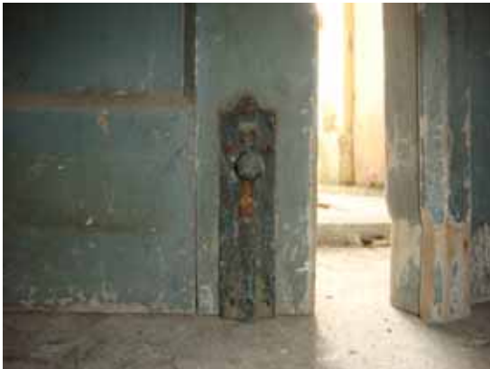
照片 6-17 門作五金生鏽、斷裂、佚失損壞
