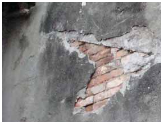
照片 3-30 牢房南側外牆南面原斜頂痕跡
