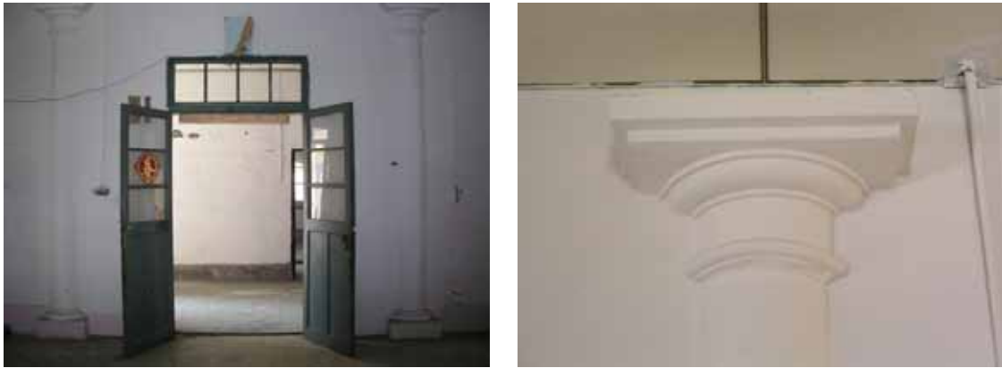
照片 4-81 水產試驗場（英國領事館）原一般辦公室內側牆對柱
