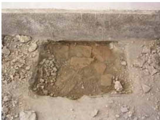
照片 3-1 中央通廊地坪清理
