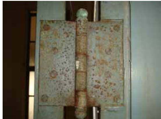
照片 6-17 門作五金生鏽、斷裂、佚失損壞
