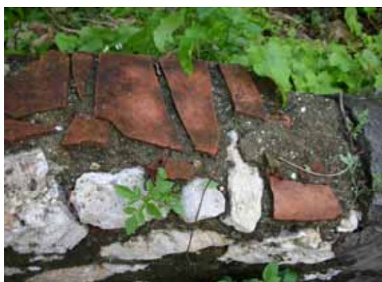
照片 4-69 登山古道矮牆頂端收頭瓦料
