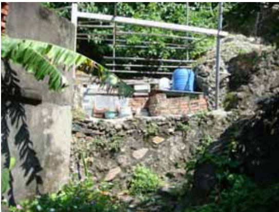
照片 4-104 山腳原僕役房後側平台
