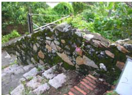
照片 4-114 階梯旁的矮牆
