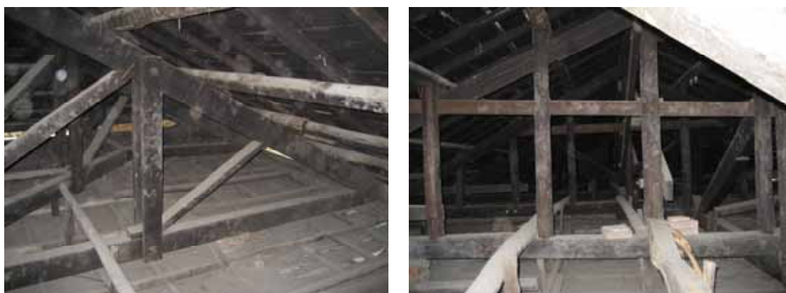
正同柱式木桁架
