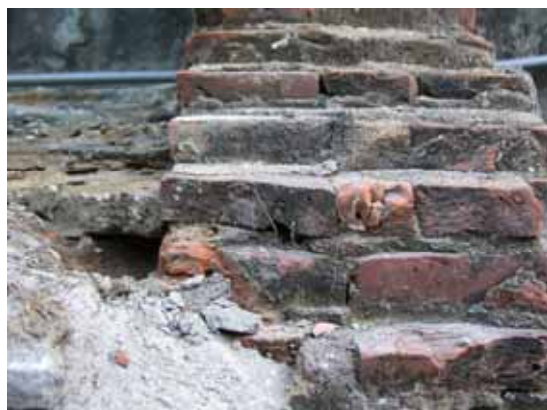
牢房外牆之閩南磚
