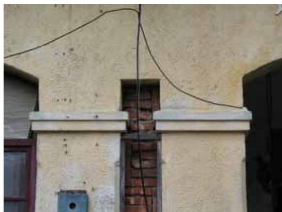
照片 4-49 柱頭外凸線腳
