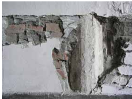
照片 4-52 獨立柱旁牆面刨除
