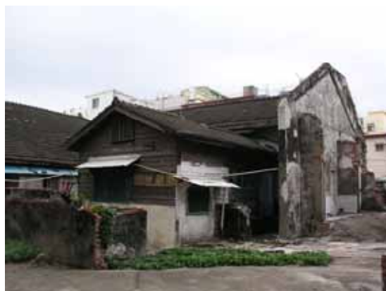
照片 4-11 原僕役房右側增建和式小屋
