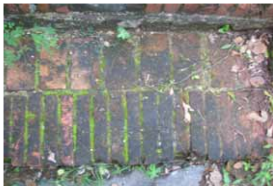
照片 4-113 紅磚砌築階梯
