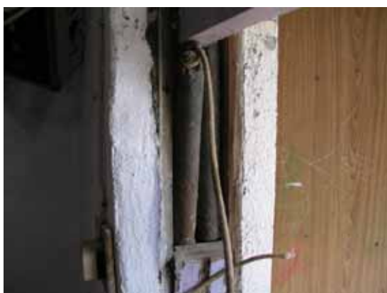
照片 4-58 上下推窗平衡錘
