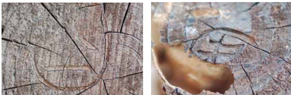
紅檜受吊木構件留有「大一」烙印
