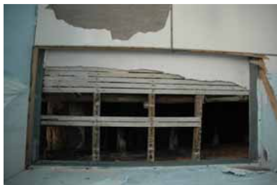
照片 4-83 天花板層次
