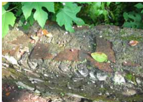
照片 4-115 階梯旁的矮牆頂端覆瓦
