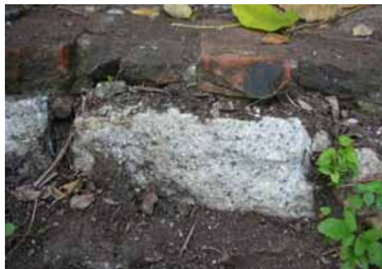
照片 4-111 磚石混砌階梯
