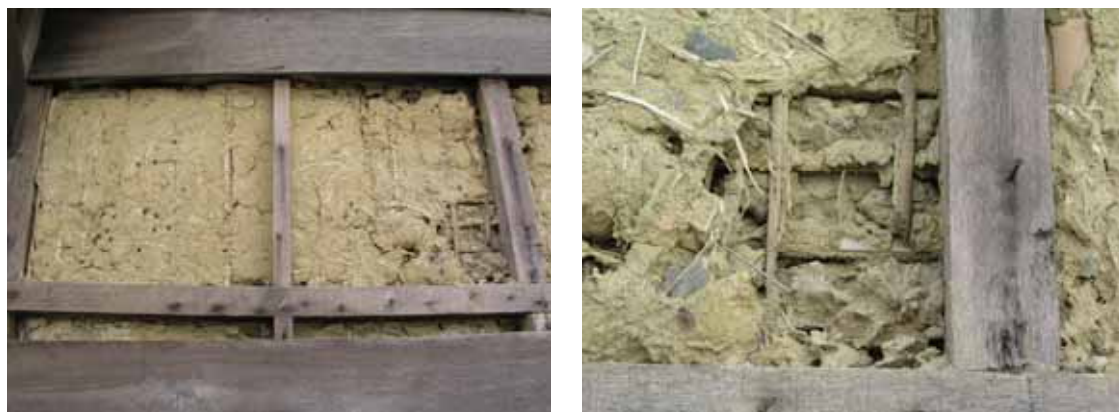
照片 4-44 水產試驗場真壁造小舞（編竹網片）
