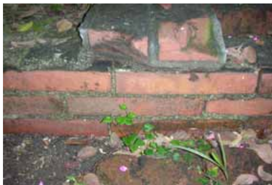
照片 4-112 紅磚砌築階梯
