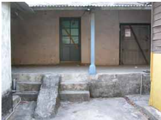
照片 4-9 廊道地坪填高
