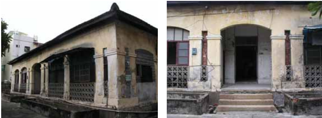
照片 4-75 水產試驗場現況立面及外牆裝修
