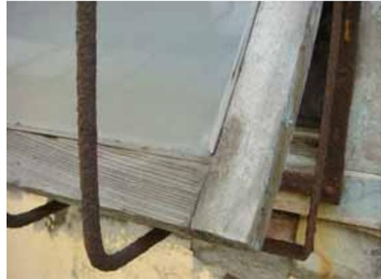
照片 6-19 窗作面漆風化剝落損壞
