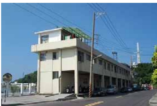
照片 7-5 海巡所的二層建築
