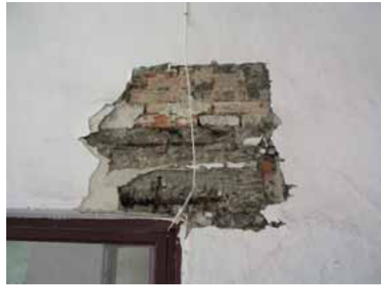
照片 3-21 西側門上方之鋼筋混凝土門楣
