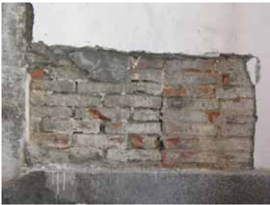
照片 3-20 西側壁面門孔痕跡
