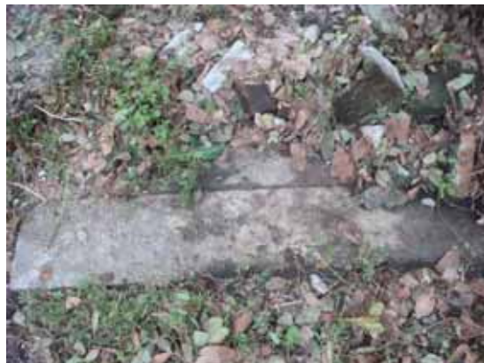
照片 3-10 階梯及放風庭院地坪清理
