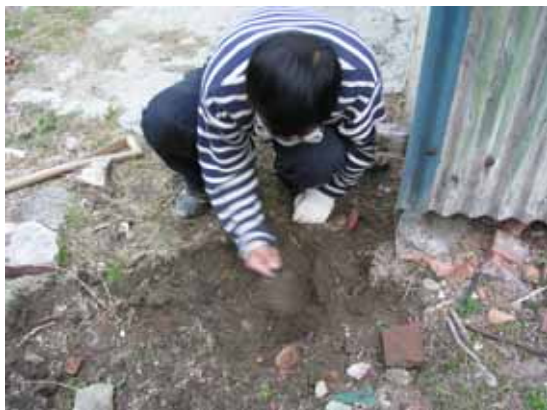
照片 3-9 牆基周圍及內部清理
