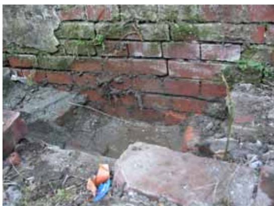
照片 3-16 排水溝清理
