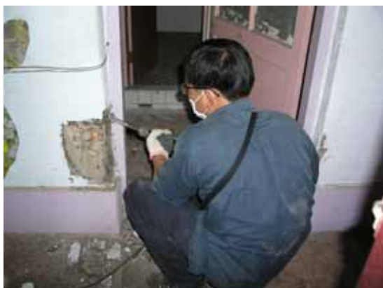
照片 3-25 西側辦公室之北向牆面門邊清理
