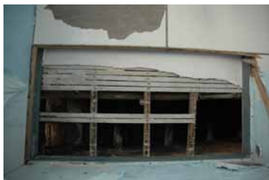
照片 3-32 原巡捕房辦公室之夾板天花與漆喰天井
