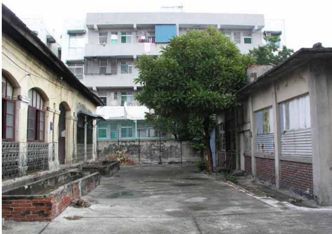
水產試驗場正立面及前方增建之漁業生物研究室
