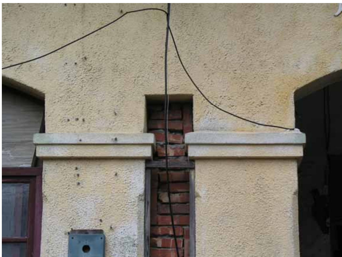
迴廊磚柱：併柱
