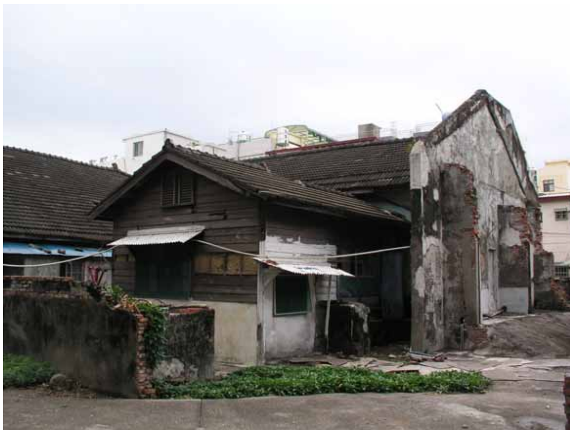
巡捕房左側增建和式小屋及監牢區山牆面
