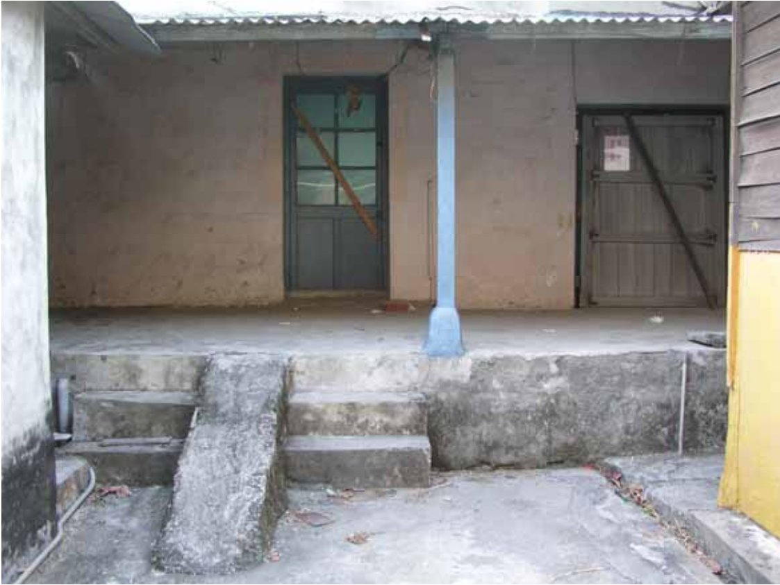
巡捕房左側走廊
